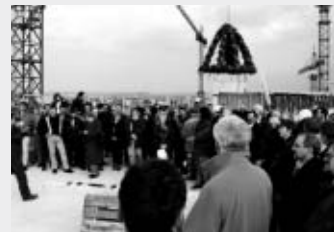
26. März 1997 Richtfest in Kaditz-Mickten an der Flutrinne
